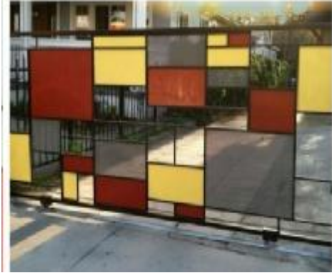
شكل رقم ( ١٩ ) يوضح تصميم لبعض البوابات الحديدية المستوحاة بشكل مباشر من اعمال الفنان التشكيلي موندريان والمنفذه من القطاعات الحديدية المصمطة والمفرغة مختلفة المقاسات، المصدر www.gatesnfences.com/Automatic Driveway gates 1.html
