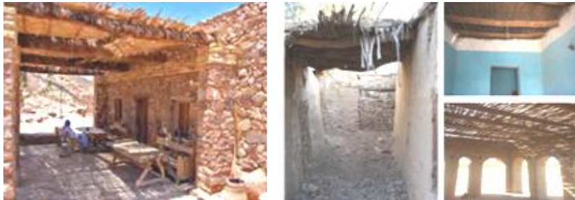
الشكل (١٣) يوضح استخدام جريد النخل في التسقيف في المنازل و لتظليل الشوارع من أشعة الشمس الحارة، المصدر: بحث ميداني ٢٠١٥
