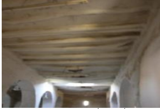
شكل (١٧) يوضح تشطيب الأسقف في أحد مساجد مدينة الباويطي، مصدر: بحث ميداني ٢٠١٥
