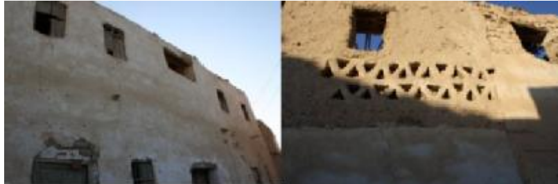
شكل(٢١) يوضح استخدام فتحات صغيرة و يرجع السبب أيضاً الى القدرة الانشائية للمواد المحلية في البناء و يحمل المثلثات الطابع الشكلى لمدينة البايطي،المصدر:بحث ميداني.
