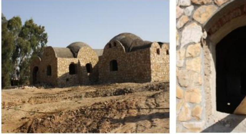
شكل (١٠) يوضح منشأ سكني للشيخ القطري مستخدم الطوب و الأسمنت في البناء و التغطية بالحجر الرملي الذي يعتبر من المواد المحلية الطبيعية المتوفرة في البوايطى في الواحات البحرية، المصدر: Christain ٢٠١١
