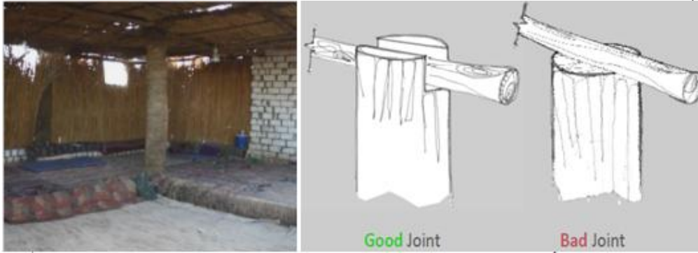
الشكل (١٥) يوضح استخدام أشجار الزيتون و الطريقة المثلى للتقطيع و تثبيت جذوع النخل عليها ايضا كعناصر لتثبيت الأسقف في الانشاء. المصدر: بحث ميداني ٢٠١٥
