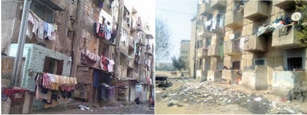
نماذج توضح عيناتلمساكن الإيواء في محافظة كفر الشيخ ومدينة المنصورة و تردى مستوي المباني و الطرق
