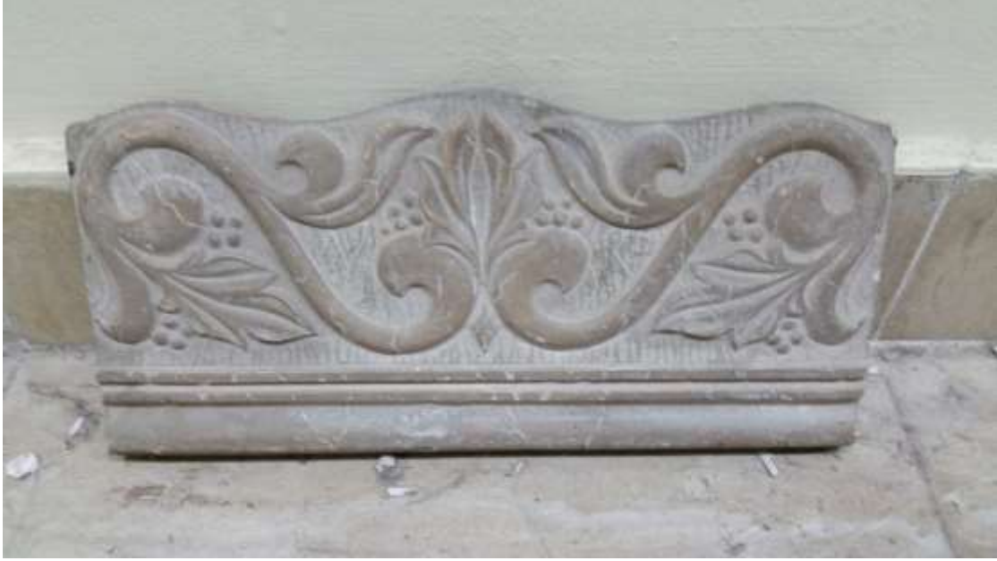
شكل (13) من أنواع التكريسات الخارجية (كورنيشة)، بوليستر بتأثير حجر قديم (الباتينة).
