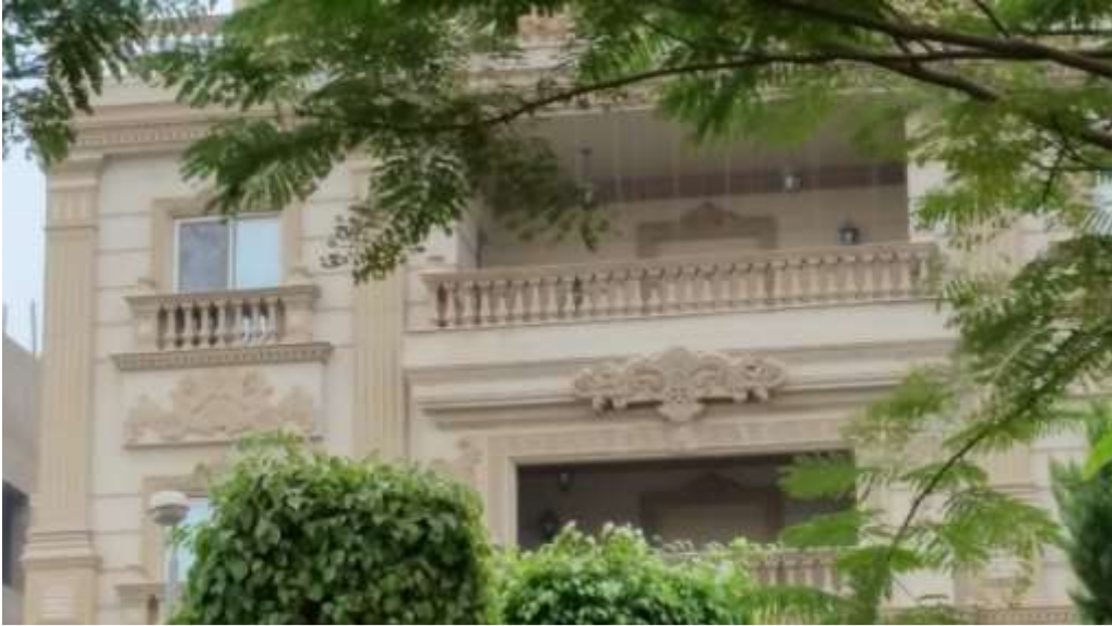
شكل (4) منتجات تجميلية من البوليستر المقوى على واجهات المباني.
