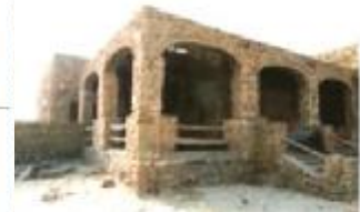
نظم البناء في سيوة من الأحجار المرصوفة أفقياً، رأسياً ثم تحمل المجاريد فوق تلك الدعامات وذلك في اتجاه واحد، ثم يستكمل بعد ذلك مراحل إنشاء السقف
