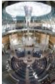
شكل (١٧) النظم التكنولوجية الفعالة المستخدمة في الإضاءة الطبيعية للحيز الداخلي "المخروط الضوئي"
