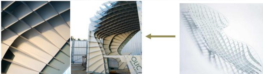
شكل (٣) يوضح استخدام تقنيه التصنيع الرقمي في تنفيذ الوحدة حيث استخدم نظام (Waffling system) في تصميم الوحدة.
