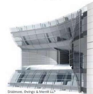
شكل (٢٣) مبنى pearl river tower يوضح فتحات بالمبنى لتوليد الطاقة بالتوربينات
