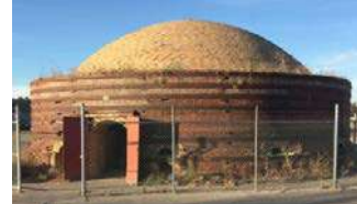
شكل (٢) الفرن التقليدي الذي يحرق مواشير الصرف بطريقة الطلاءات الملحية
