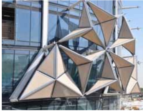
شكل (٤) ميكانيزم الحركة لوحـدات الاظلال و التحكم فى زوايا فتحها و غلقها .
