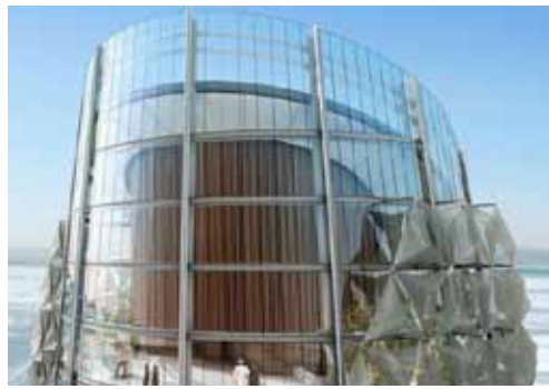
شكل (٣) في واجهته الخارجية تم تغطية المبني بقطع خلية النحل و ذلك للمساعدة على التحكم باكتساب حرارة الشمس.
