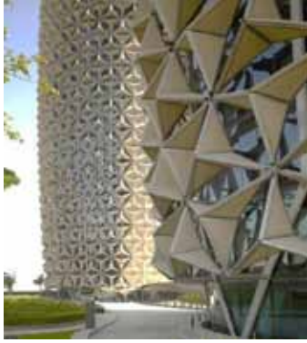
شكل (٥) الأبراج بلورية "ابراج البحر Al Bahr towers" -الوحدات المظلمة مغلقة و الأخرى المفتوحة.
