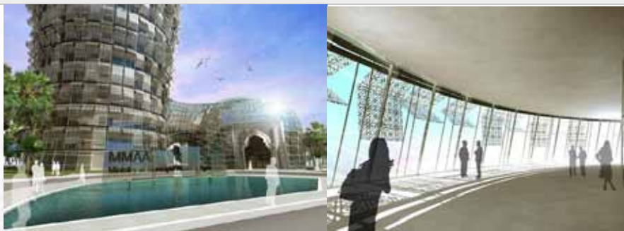
شكل (24) استخدام نظام التظليل في مبنى وزارة الشؤون البلدية والزراعة
