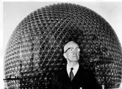
شكل (6) القبة الجيوديسية (geodesic dome)
