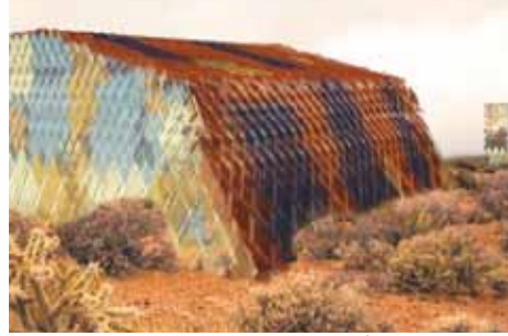
شكل (18) مبنى S.C.A.L.E.S.
