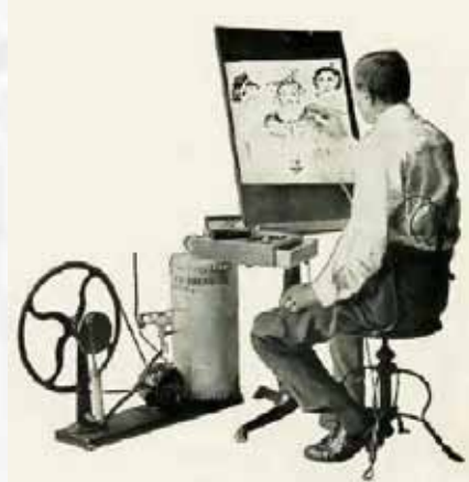
شكل 2: صورة منشورة أوائل القرن العشرين تظهر رجلا يستخدم الإبربرش اعتمادا على مضخة هواء كهربائية ميكرو
