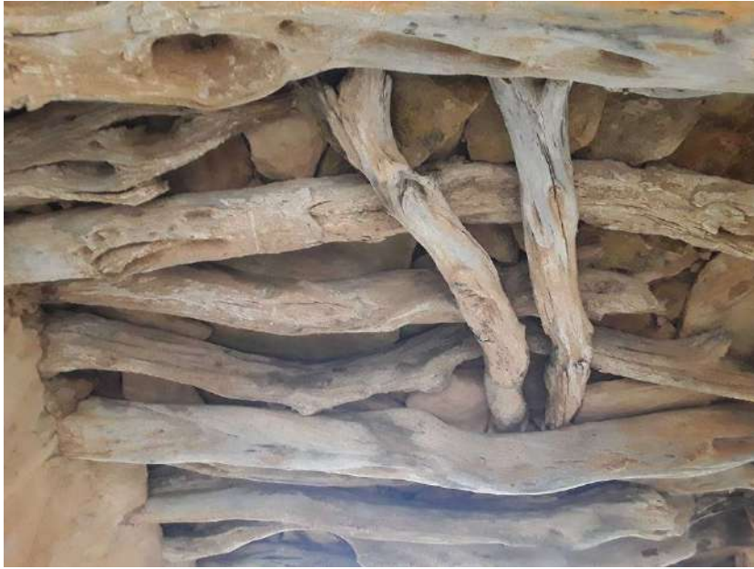
صورة ٤ استعمال الخشب في السقف المسطح
