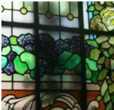
صور توضح ابواب الزجاج المؤلف بالرصاص في قصر الزعفران
