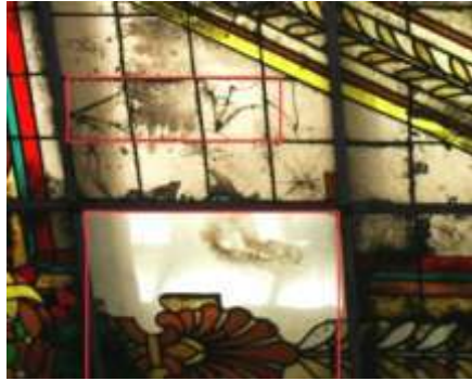
الصورة توضح الفقد لبعض اجزاء الحشوة
