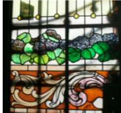
صور توضح ابواب الزجاج المؤلف بالرصاص في قصر الزعفران
