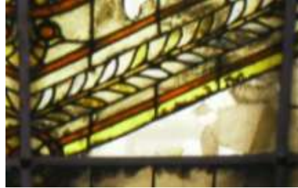
صورة توضح انفصال الرصاص عن الزجاج
