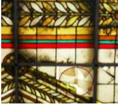
الصورة توضح الكسر في بعض اجزاء الحشوة
