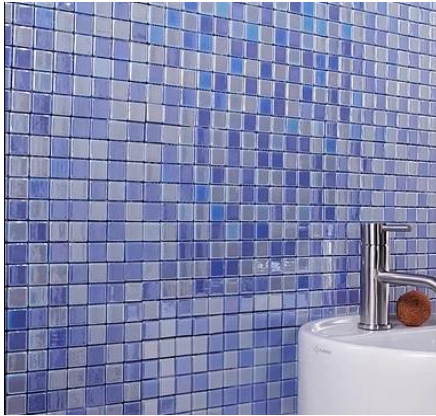
شكل (9 أ، ب): يوضح استخدام الصبغات الفوسفورية في البلاطات الزجاجية (الموزاييك) والمستخدمة كتنكسية للحوائط، وفي الشكل 9أ يظهر الحائط في الإضاءة العادية والشكل 9ب في الظلام حيث يتوهج الحائط بدرجات من اللون الأزرق. 2
